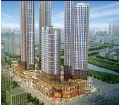
건설 현장의 안전 관리 및 침입 / 화재예방 아파트, 빌딩 / 상가 등의 침입, 화재 감지
